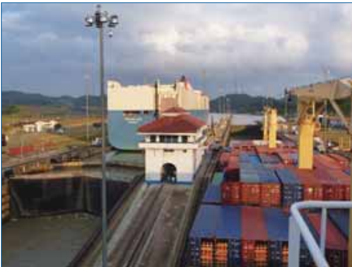
Einfahrt in die Pedro-Miguel-Schleuse
